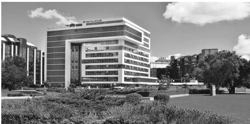
Slika 4.1. Objekat Delta House
